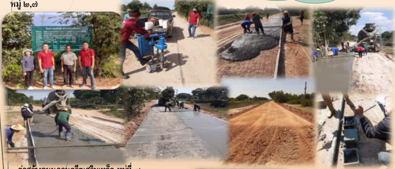
ก่อสร้างถนนคอนกรีตเสริมเหล็ก หมู่ที่ ๓
